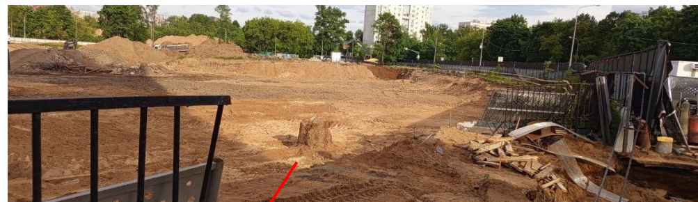
ПОДНЯТЫЕ КОЛОДЦЫ КАНАЛИЗАЦИИ
